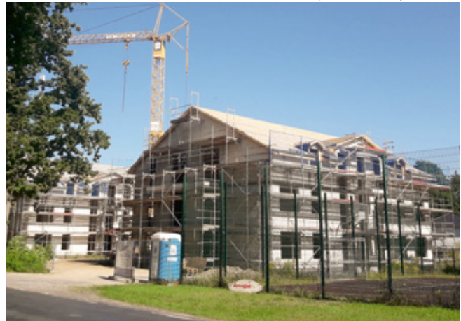
↑ Neuestes Bauprojekt der BBF Gruppe – Mehrfamilienhäuser in Bad Saarow
